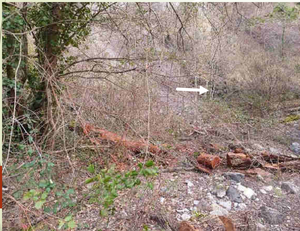
Travaux en cours : Débroussaillage des zones de dépôts des pans marneux.
