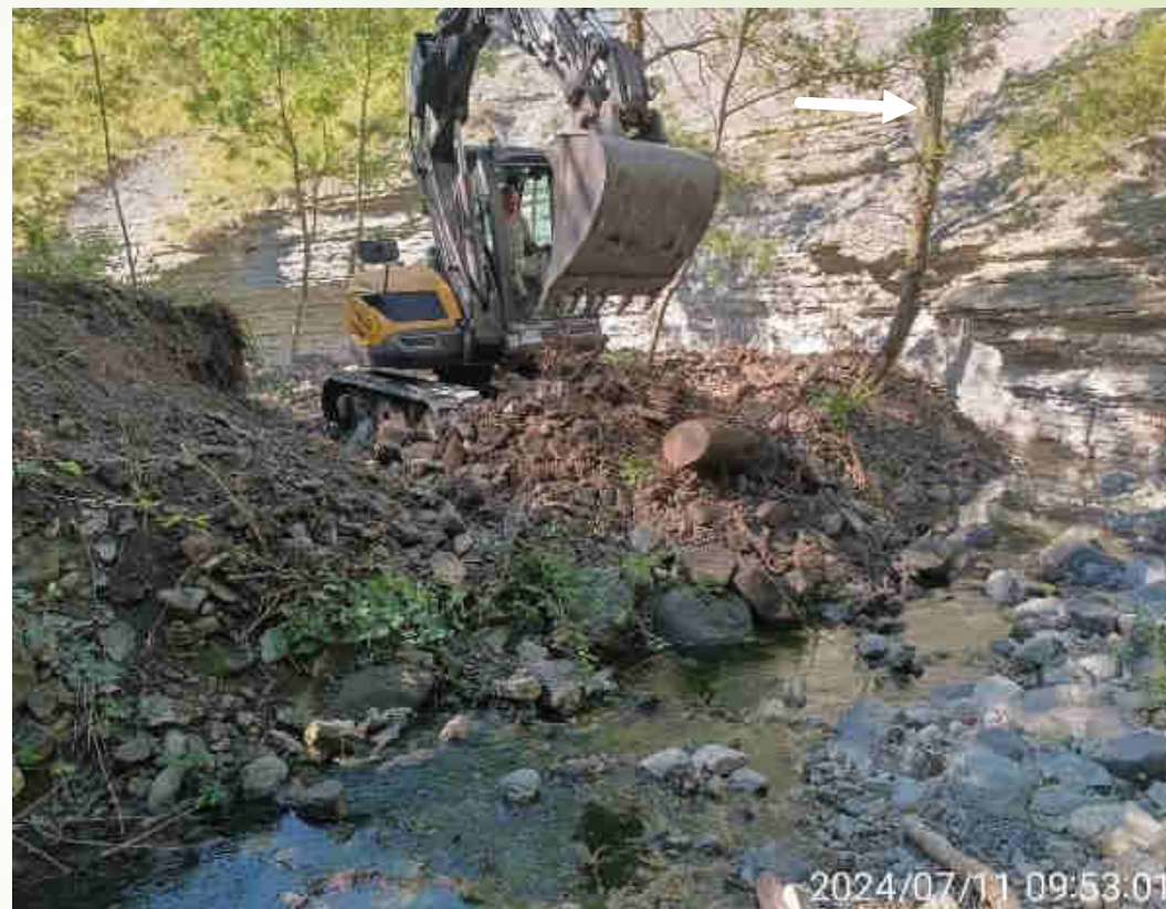
Après travaux : Déstockage des matériaux des terrasses alluviales déconnectées avec réinjection dans le lit mineur pour une remise en mouvement des bancs végétalisés.
