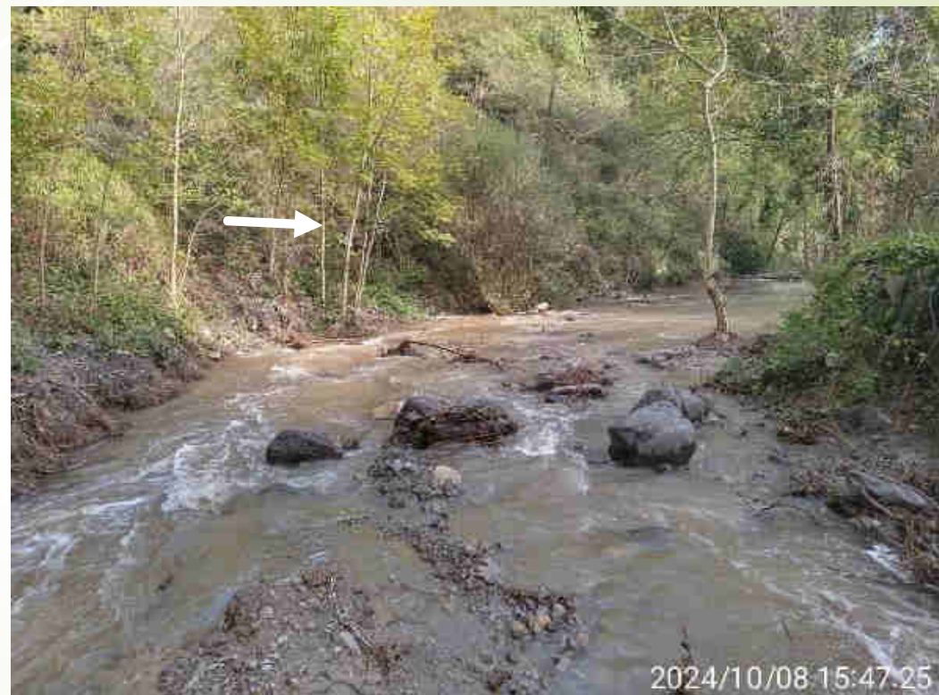
Après travaux : Fragilisation du pied des zones de dépôts pour favoriser la recharge du cours d'eau (granulométrie favorable à la création naturelle de frayère).
