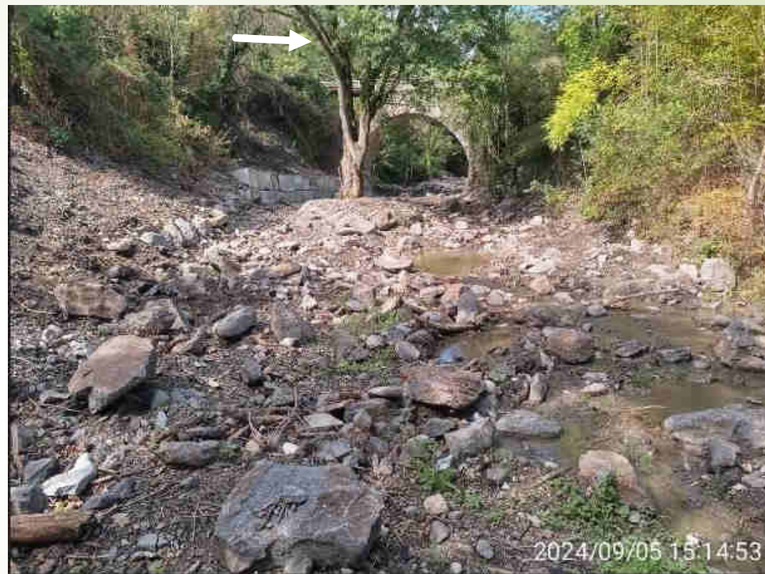
Après travaux : restauration de l'EBF avec création d'une zone de dissipation d'énergie et d'une fosse de repli.
