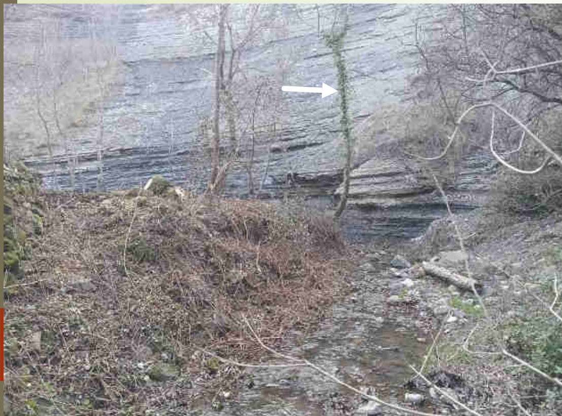
Avant travaux : Terrasse alluviale déconnectée et dévégétalisée en rive gauche avec lit mineur incisé en U (2 m de hauteur d'incision) de 3 m de largeur.
