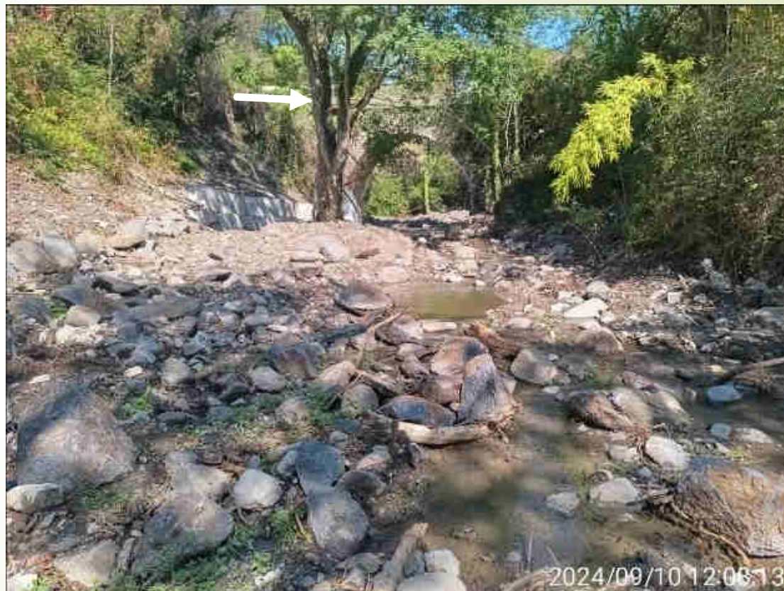
Après travaux aval R10 : fond du lit mineur en matériaux déplacés avec CG (3,2-6,4 cm) CF (1,6 -3,2 cm) , GG (0,8-1,6 cm), GF (0,2-0,8 cm) PG (13-25 cm)- PF 6-13 cm).
